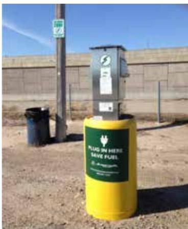
Рис. 4. Оборудование для подключения автопоезда к электросети на паркинге Newell Travel Plaza, г. Ньютон, штат Канзас, США [8]
