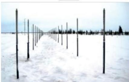
Рис. 3. Устройство термостабилизатора и расположение термостабилизаторов вдоль дорожного полотна [9, с. 11]
