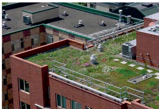
Рис. 3. Экстенсивная «зеленая» крыша на промышленном здании [11, с. 105]
